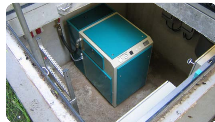
Nachblasstation in unterirdischer Bauform
