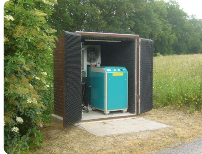
Betongeräteschrank mit Riemchen verklinkert
