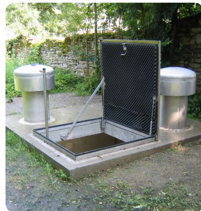
Nachblasstation in unterirdischer Bauform
