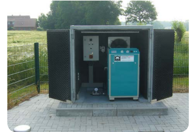
Betongeräteschrank mit 7,5 KW Schraubenkompressor inkl. Steuerung
