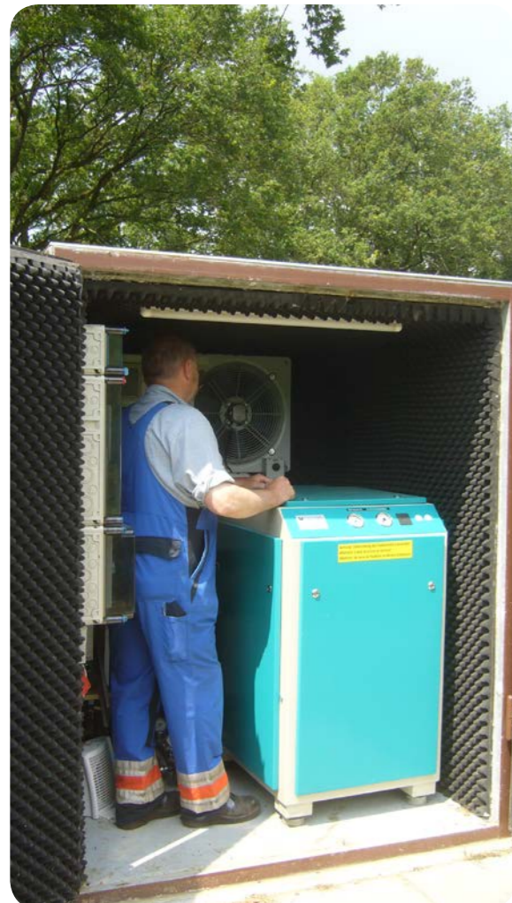
Begehbarer Betongeräteschrank
