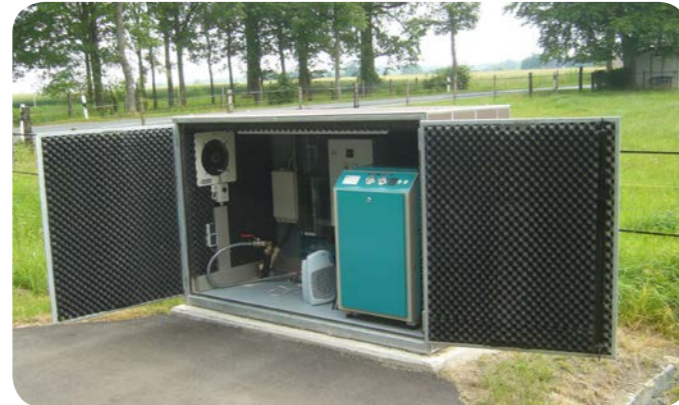
Betongeräteschrank mit einem Schraubenkompressor 5,5kW inkl. Kompressorsteuerung und integrierter EVU-Einspeisung
