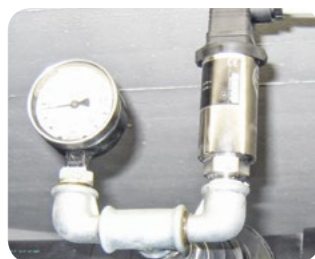
Optionale Druckerfassung in der Rohrleitung
