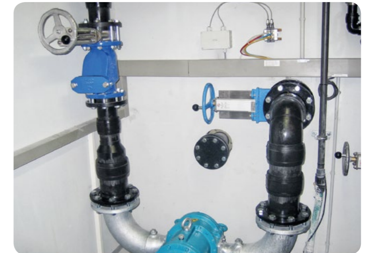
Nachrüstung Drehkolbenpumpe zur Erhöhung der Förderleistung
