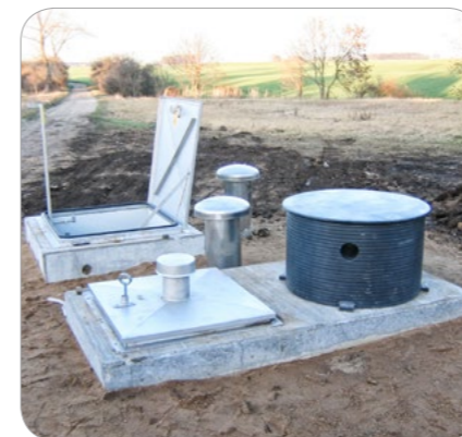
Außenansicht des Pumpwerkes
