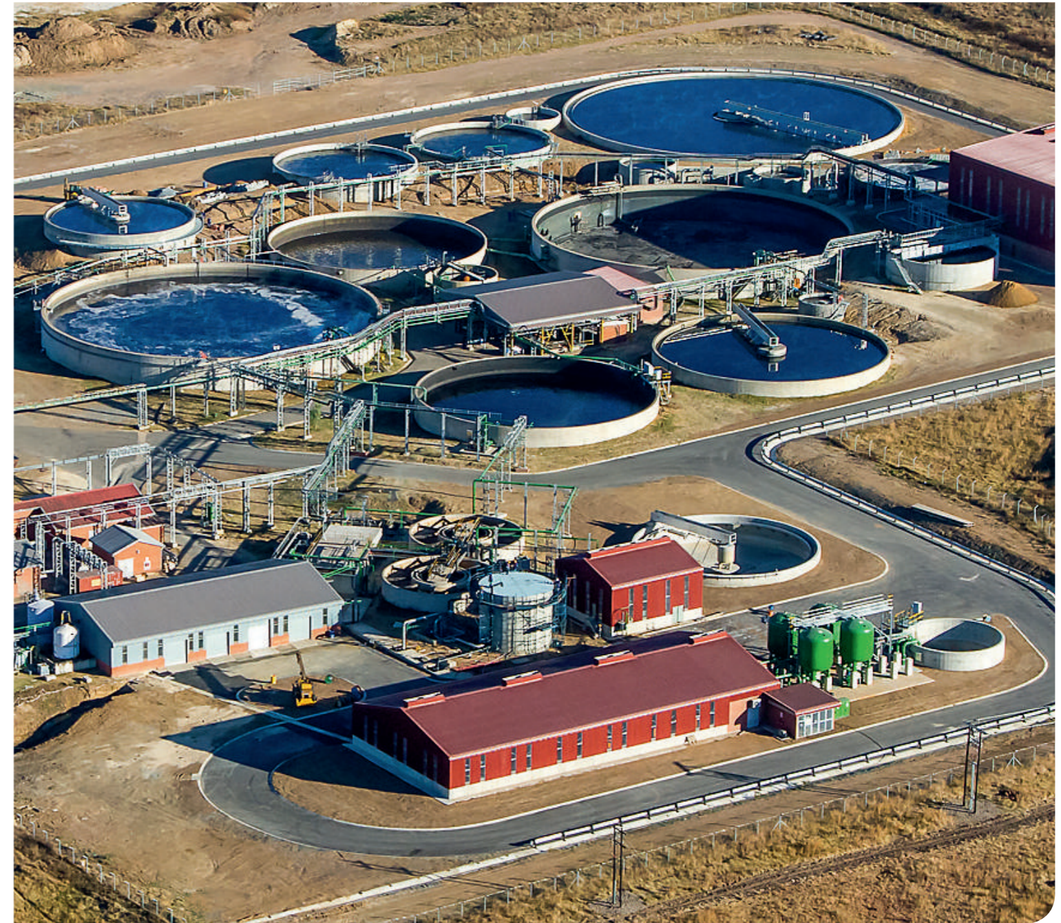
Betriebskläranlage ArcelorMittal, South Africa Sewage treatment plant ArcelorMittal, South Africa
